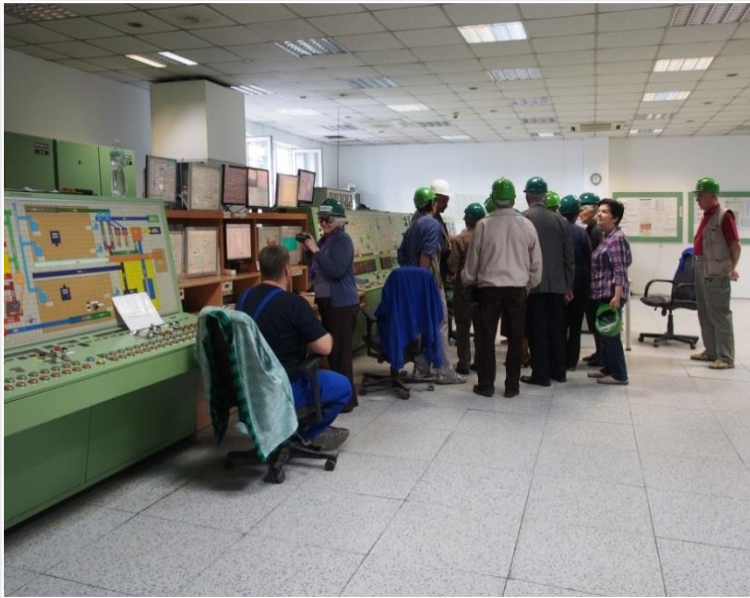
Zakład ma zdublowany układ monitoringu do kontroli zanieczyszczeń
