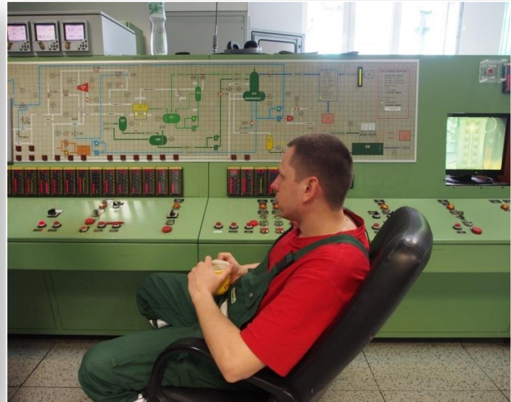
Zakład ma zdublowany układ monitoringu do kontroli zanieczyszczeń
